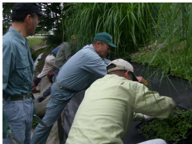
角度の急な法面にも、しっかりと植えました。
