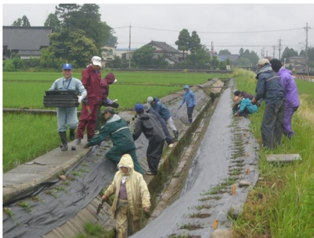
21日は、雨が心配されましたが、無事に作業を終えることができました。4月より、法面整形、シート張り、イワダレ草の植栽とほぼ毎週日曜日に作業が入ったにも関わらず、積極的に参加いただき、ありがとうございました。(カッパの中は蒸し暑かったです。)
