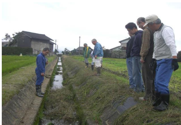
この後、この草は除去し、水路は通常の流れを取り戻しました。
