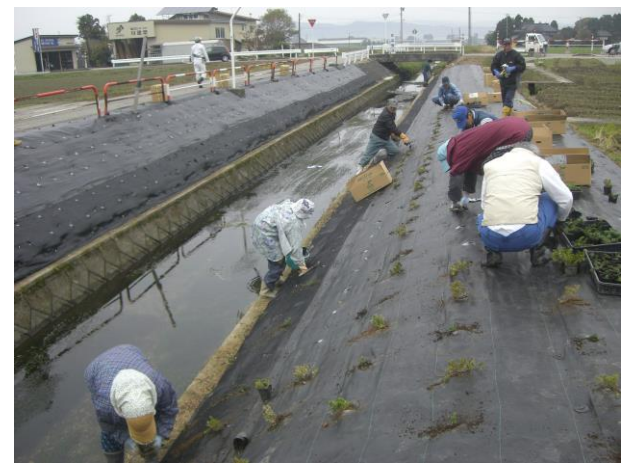
川に落ちないように気をつけながら作業を進めます。
